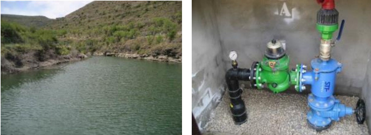
Ilustración 37. Imagen de embalse y de los hidrantes.
