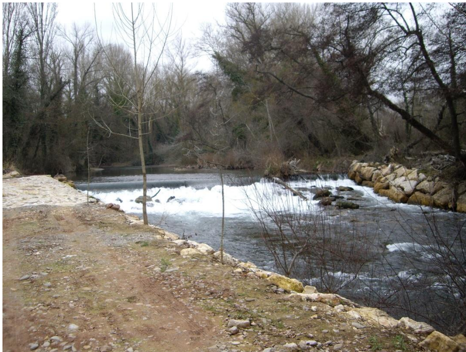
Ilustración 63. Situación previa a la actuación. Salto de azud.
