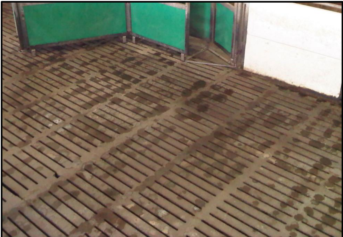
Revestimiento de suelo con un solo tipo de rejilla
