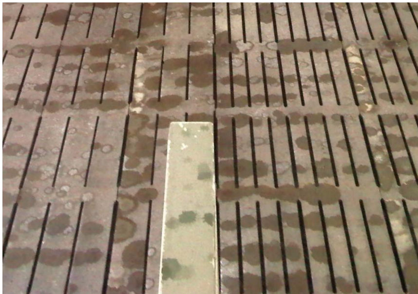
Revestimiento de suelo con dos tipos de rejillas de hormigón
