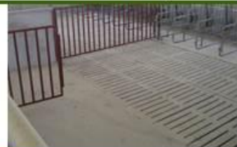
Suelo de hormigón emparrillado y sin emparrillar
