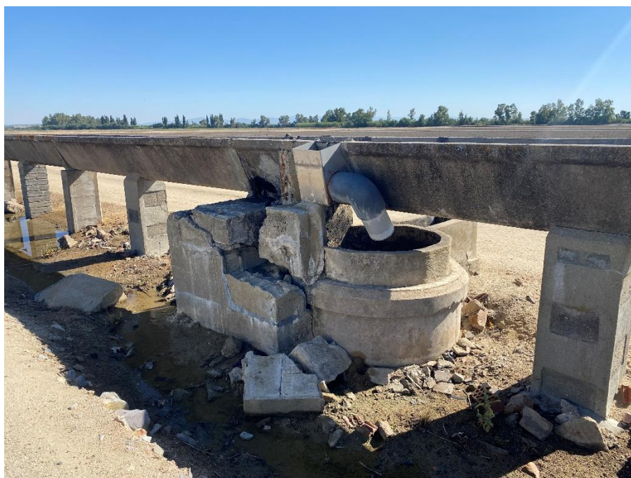
Ilustración 8.- Estado actual de la acequia A-XVIII-F-11.
