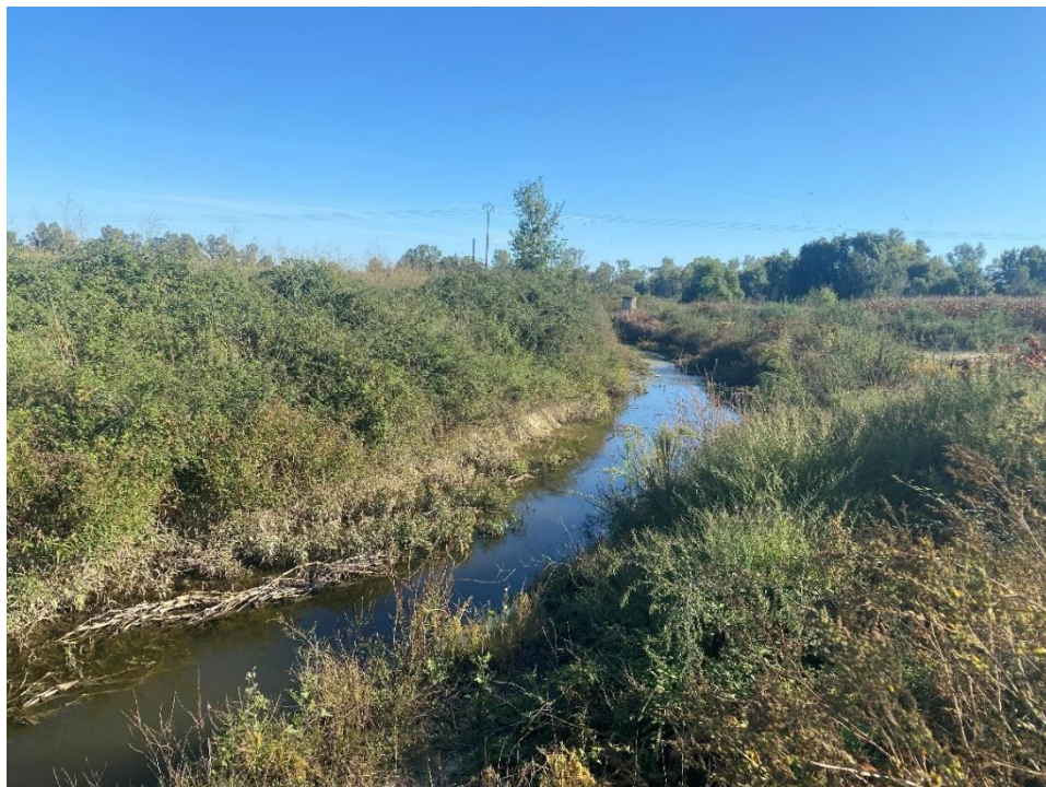
Ilustración 55.- Fotografía margen derecho tramo Arroyo S/N
