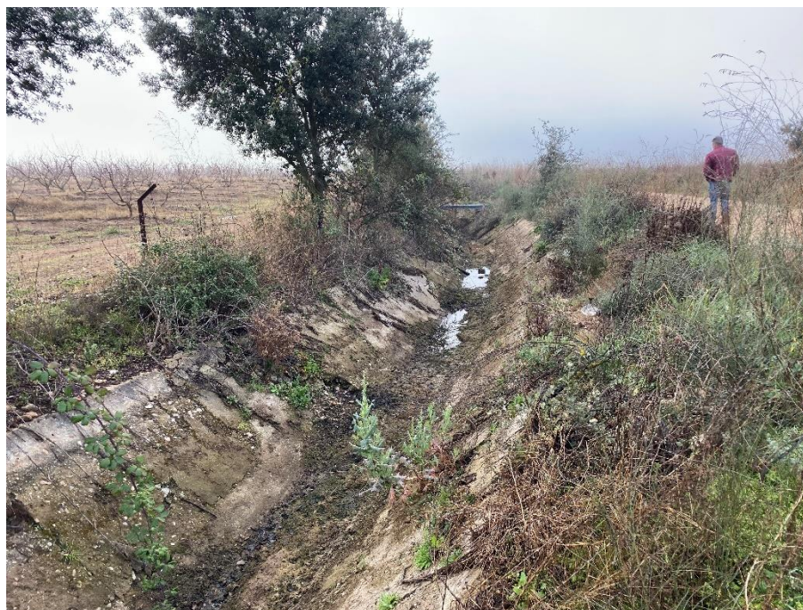
Ilustración 3.- Estado actual de la acequia A-II-B
