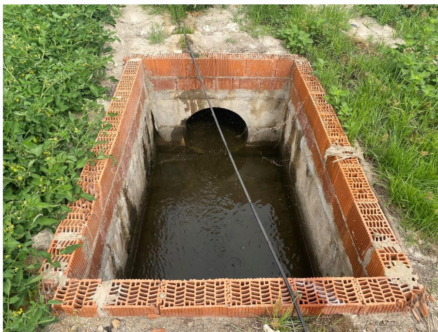
Ilustración 13.- Arqueta intermedia del tramo entubado de la acequia A-XXVIII-C.
