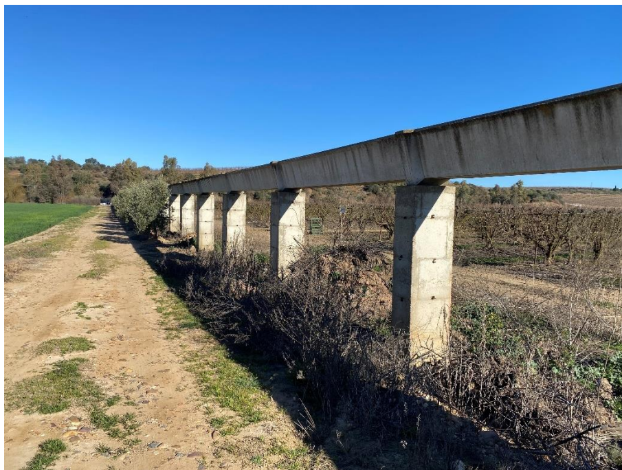
Ilustración 4.- Acequia prefabricada a desmontar para recuperar A-II-B-2.
