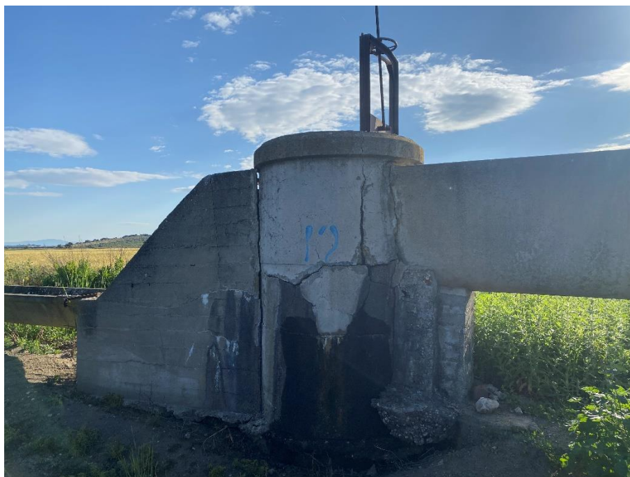
Ilustración 9.- Estado actual de la acequia A-XX-A-8-PRIMA.
