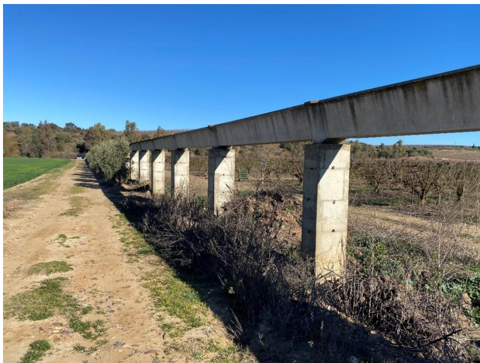
Ilustración 59.-Fotografía del estado actual de la acequia
