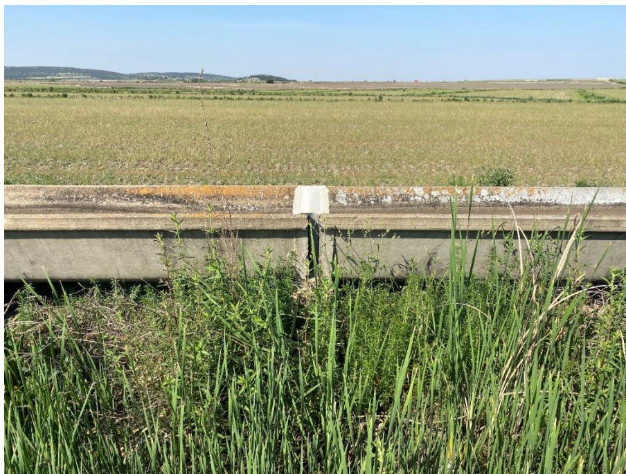
Ilustración 7.- Estado actual de la acequia A-XVIII-F.
