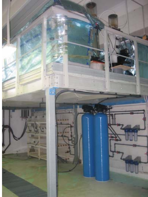
Figura 1. Sistemas de filtración y control térmico del agua para la hatchery de moluscos del IRTA.
