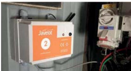
Nuevo dispositivo dedicado a la ventilación, que hace posible activar la ventilación de forma remota desde un teléfono inteligente u ordenador, pero también funciona en modo automático. Detecta la temperatura exterior y la temperatura del grano en tiempo real e inicia la ventilación en el momento adecuado para mantener las condiciones óptimas de almacenamiento. Para el control de la temperatura utiliza diferentes sondas.
