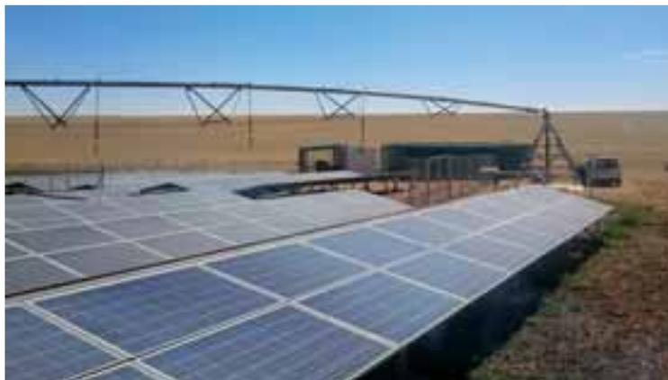
Figura 10. - Instalación de riego con energía eléctrica solar de alta potencia (Sistemas de Riego Solar).
