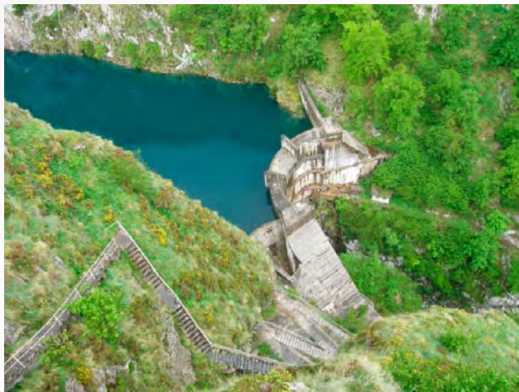
ILUSTRACIÓN 36 PRESA DE LA JOCICA (RÍO DOBRA)
