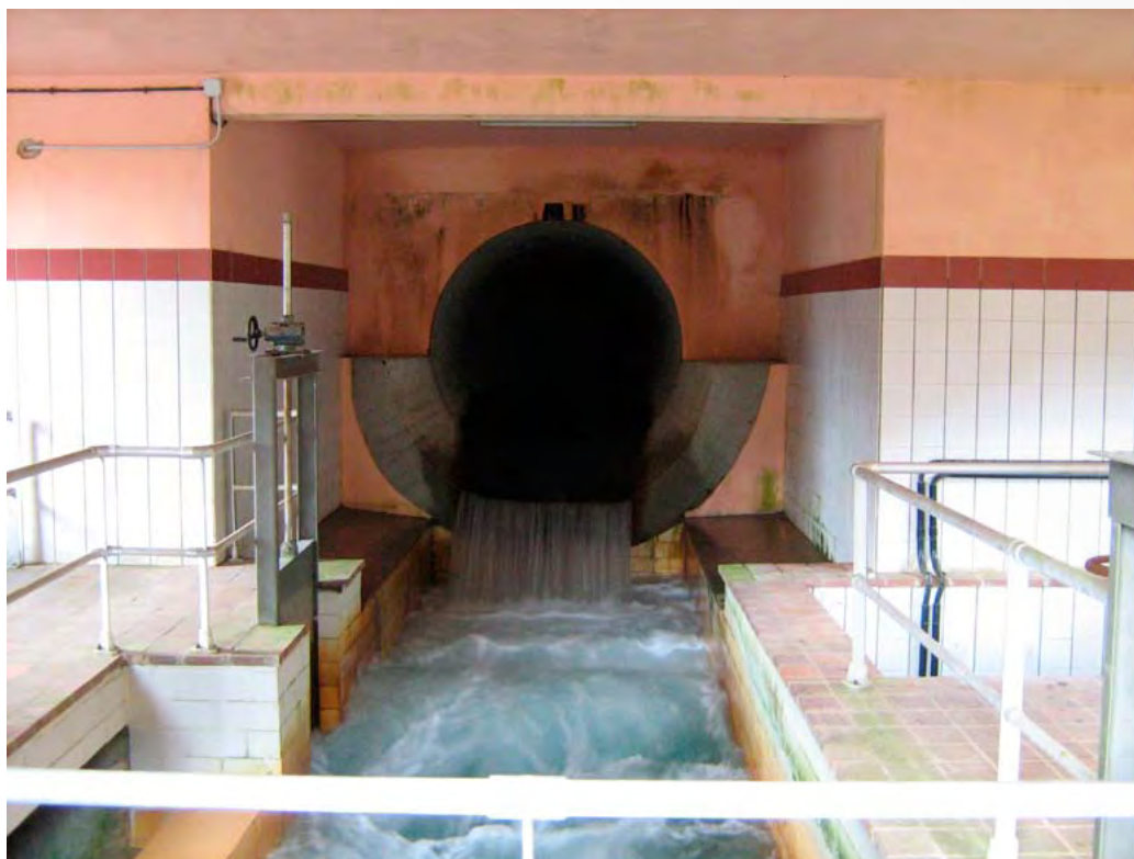
ILUSTRACIÓN 59 SALIDA DEL TÚNEL DEL ÁRAMO-ABASTECIMIENTO A OVIENDO
