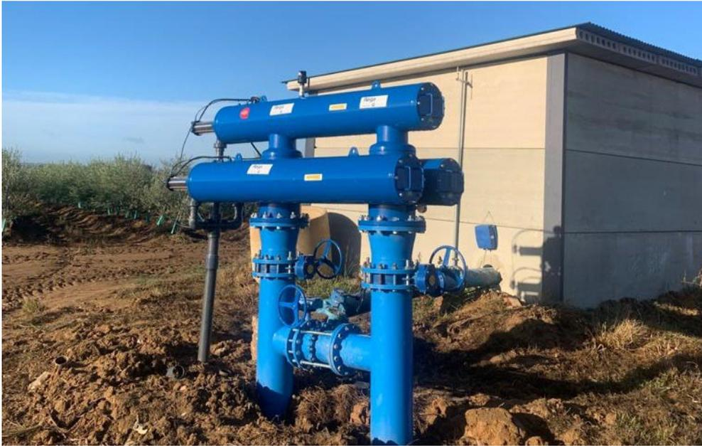
**Figura 4.** Cabezal de filtrado sobre red de riego de la comunidad
