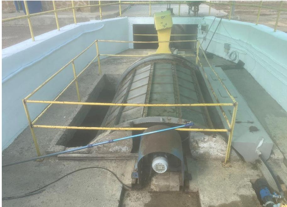
**Figura 2.** Filtro rotativo de limpieza
