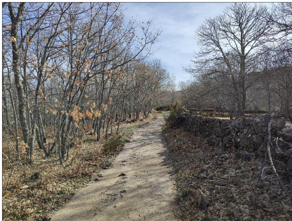
Ilustración 42. Camino donde se alojará la red de distribución y riego.
