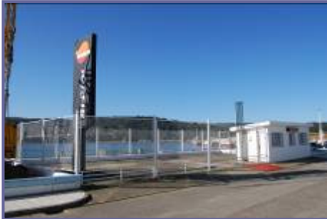
Suministro de combustible
