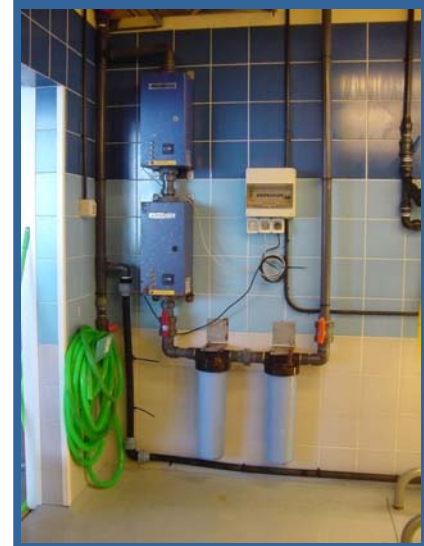
Figuras 72 y 73. Tanques de cultivo larvario y sistema de filtración y esterilización U.V.
