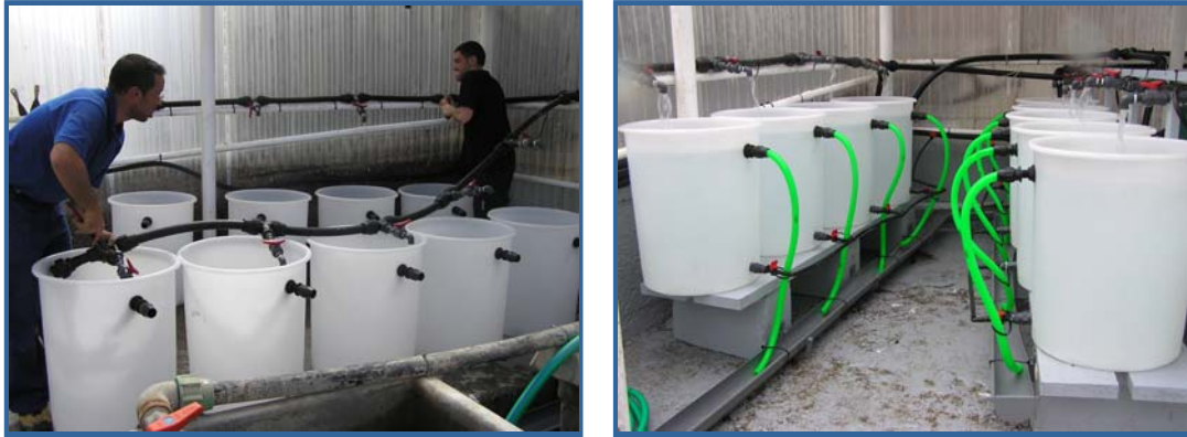
Figuras 55 y 56. Montaje e instalación definitiva de los biofiltros experimentales
