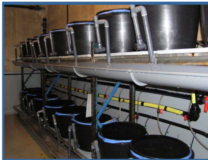
Figura 38. Instalación actual para el mantenimiento de los reproductores
