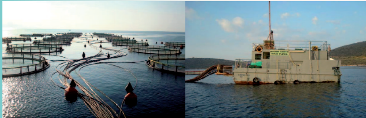
Fotografía 5: Instalación de producción ecológica de Galaxidi Marine Farm (izquierda) y plataforma de alimentación (derecha) © Galaxidi Marine Farm
