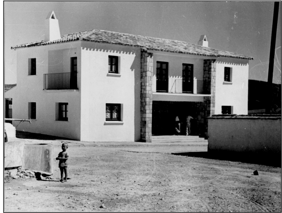
Viviendas de maestros
