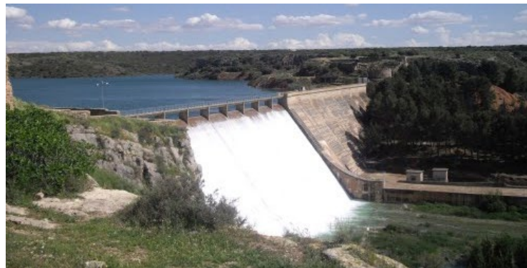
Figura 2.- Vista de la presa de Peñarroya.
