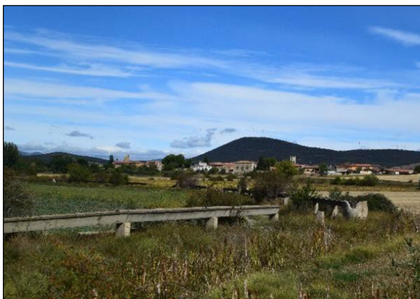
Estado actual de las infraestructuras existentes en la zona regable.
