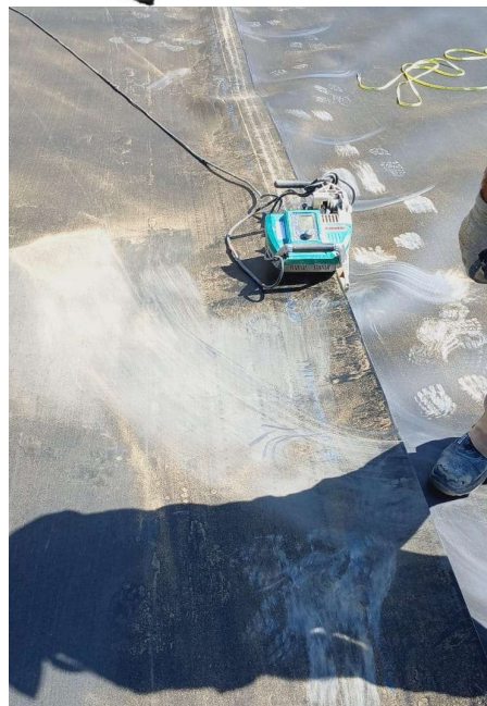
Figura 20 - Soldadura por termofusión
