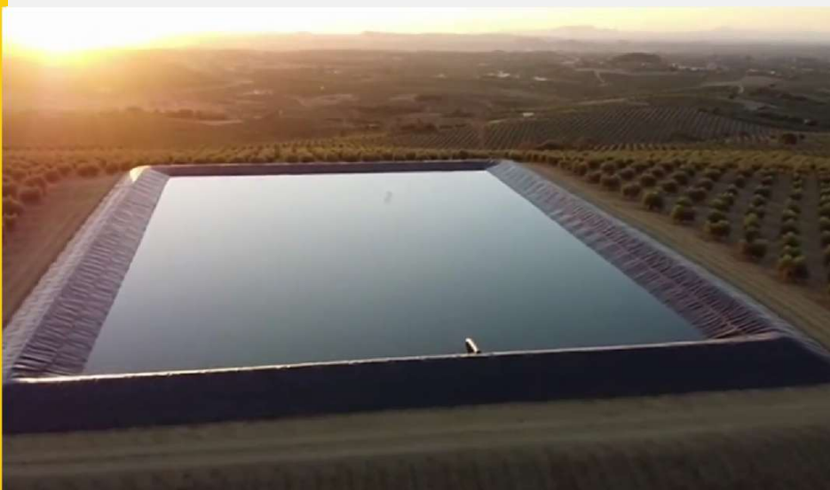
Inspección de diques
