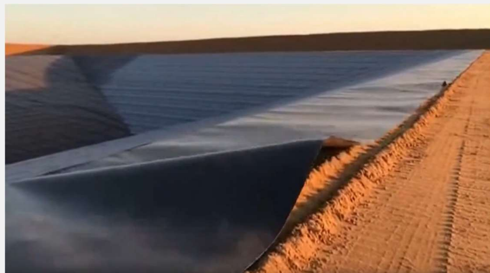
Inspección de geomembranas
