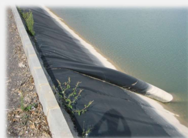
LASTRES DE TALUD INTERIOR
