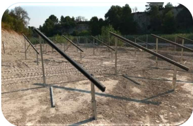
Estructura Fija hincada al terreno
