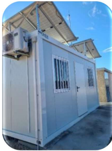
Casetas servicios auxiliares
