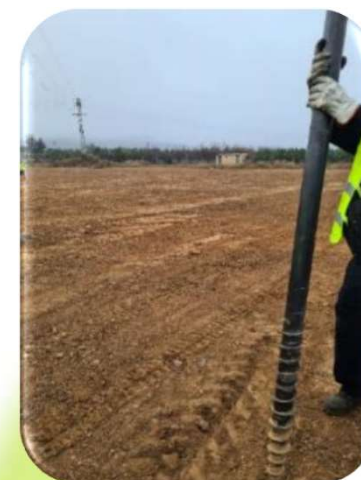
Estructura Fija con tornillo de fundamento
