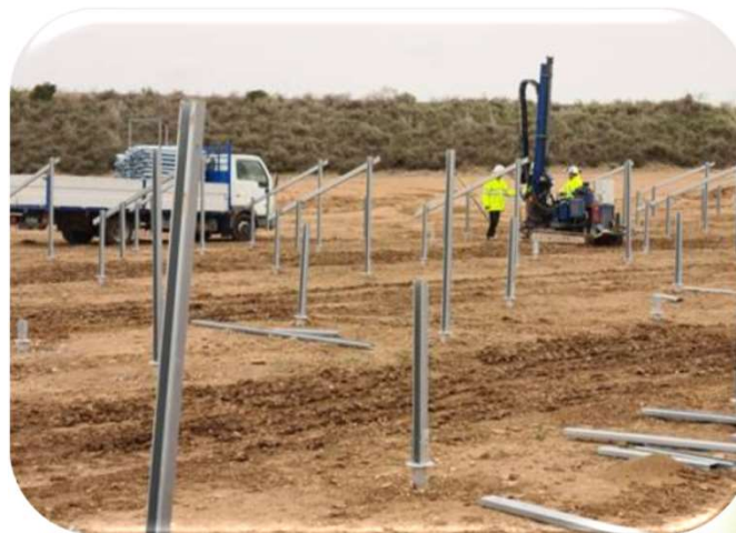
Estructura Fija con tornillo de fundamento
