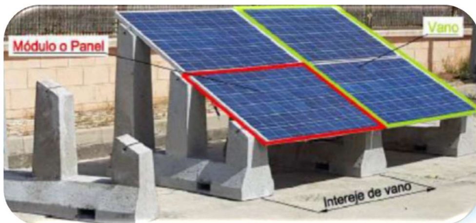
Estructura apoyada en el terreno
