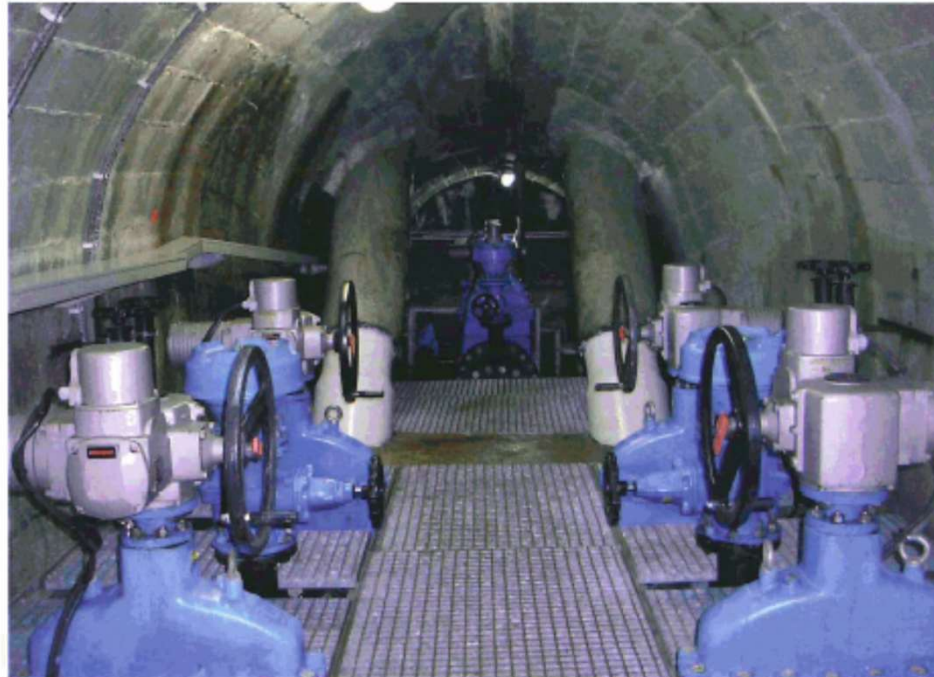
Fotografía 26.- Ejemplo de una galería de servicio hormigonada in situ (en servicio)
