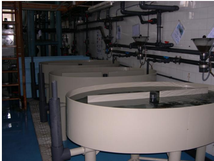
Foto 4: Tanques de cultivo de lenguado común.
