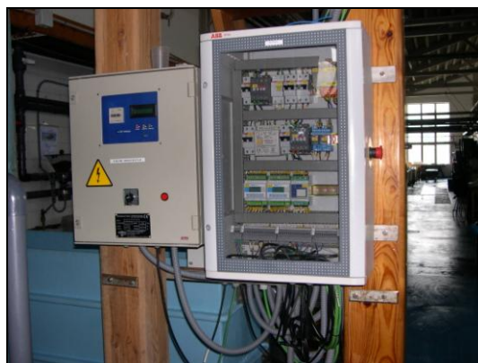
Foto 8: Sistema de regulación de oxígeno.
