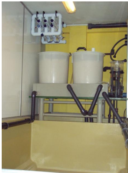
Foto 6: Equipamiento del sistema de circuito cerrado de un tanque de reproductores.
