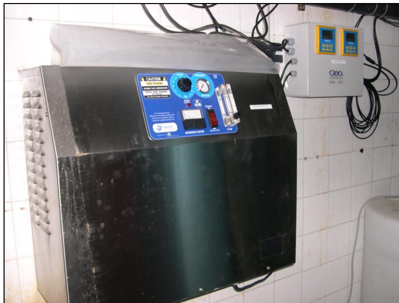
Foto 11: Equipo para la producción y control del ozono.
