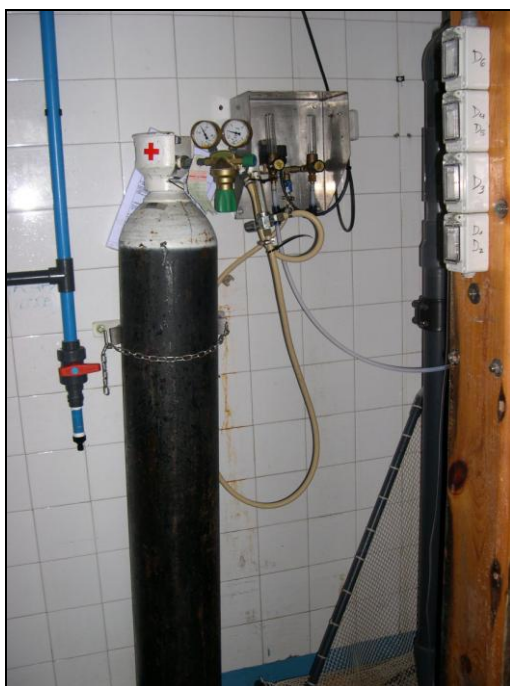
Foto 8: Sistema de regulación de oxígeno.
