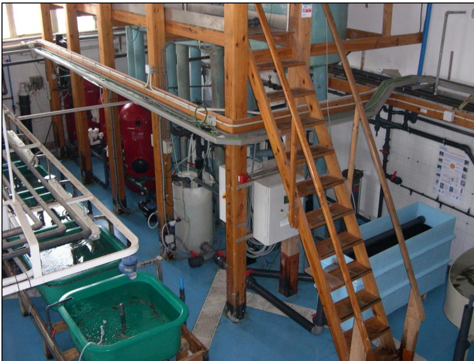
Foto 1: Visión general de las instalaciones del circuito cerrado.
