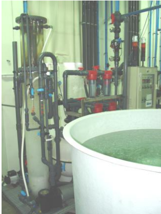
Detalle Fraccionador proteínas Controladores, Generador de ozono, sistema de alarma, sondas.
