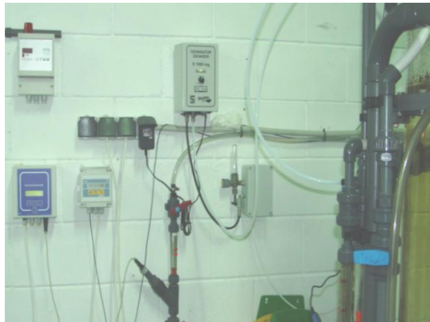
Detalle Fraccionador proteínas Controladores, Generador de ozono, sistema de alarma, sondas.
