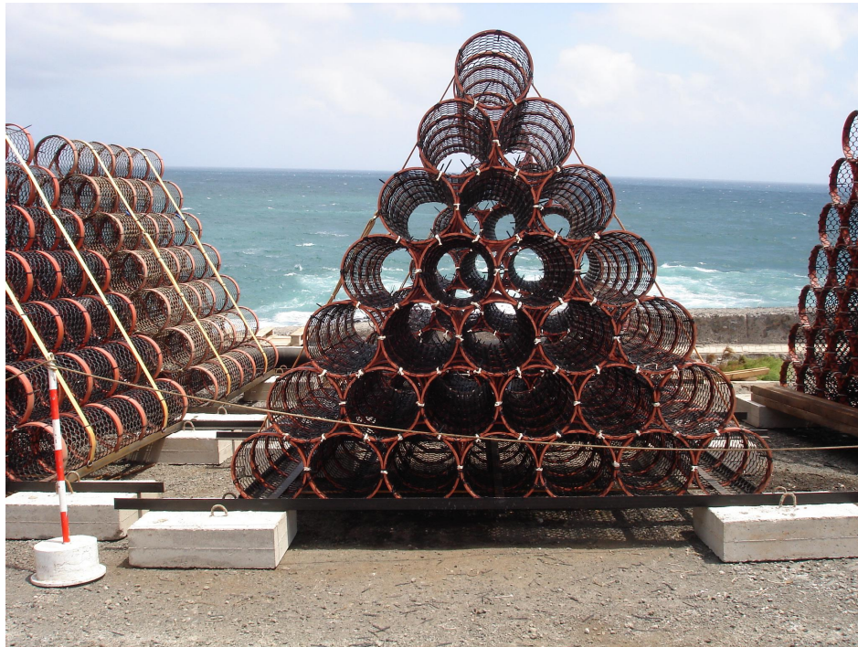
Figura 3: Biofiltros bentónicos y sistema de fondeo específico de la CA Canarias (Fuente ICCM).
