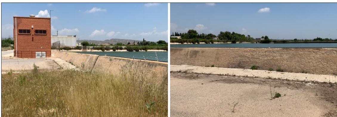
Ilustración 142: Vista del muro exterior del depósito de la 4ª elevación de Crevillente
