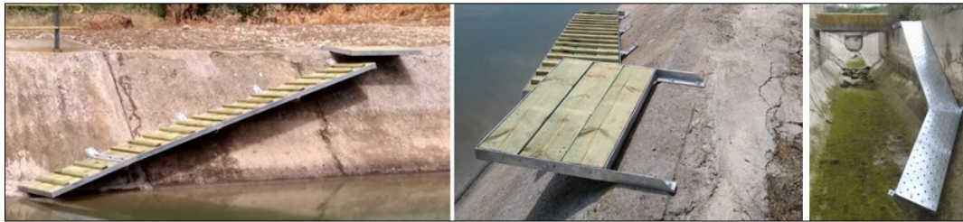
Ilustración 199: Ejemplo de rampa de escape para la fauna empleada en depósitos y canales de riego.
