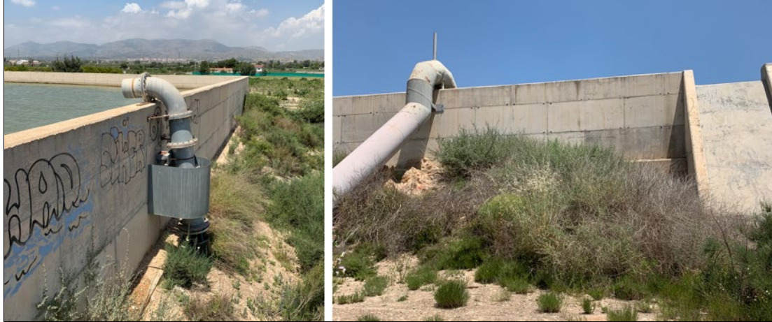
Ilustración 143: Vista del muro exterior del depósito de la 3ª elevación de Crevillente
