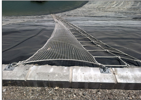
Ilustración 197: Ejemplo de red de poliéster instalada en una balsa de riego para facilitar la salida de animales y personas.
